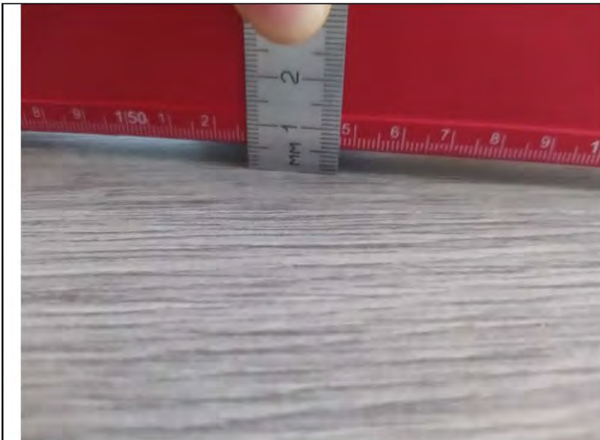
Фото №16. Измерения уровня напольного покрытия в прихожей.
