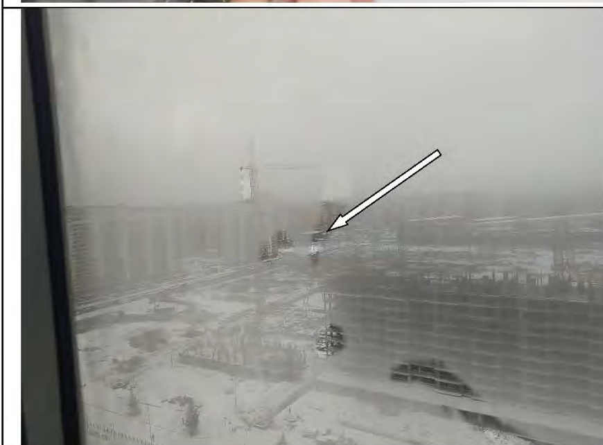
Фото №29. На стеклопакете оконного блока на балконе имеется дефект (окарины).
