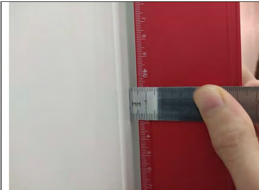
Фото №13. Измерения уровня стен в санузле.
